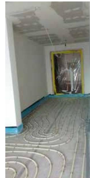
Nach meinem letzten Bericht wurde die Außenflurtür eingebaut. Im neuen, verlängerten Flur wurde die Dämmung einbracht und die Heizschlangen verlegt. Wegen der zurzeit herrschenden Kälte kann der Estrich noch nicht aufgebracht werden, aber wenn ihr dies lest, ist das bestimmt schon geschehen.
